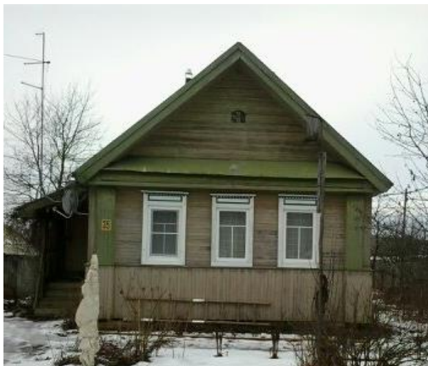
Дом обшит вагонкой.
