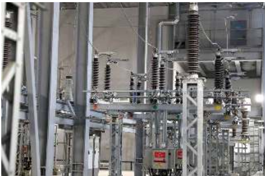
Рис. 3. ЗРУ 110 кВ ЦПС Портовая
